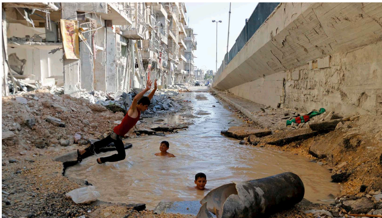
Une conduite d'eau détruite à Alep, en Syrie (© Reuters / Hosan Katan).
